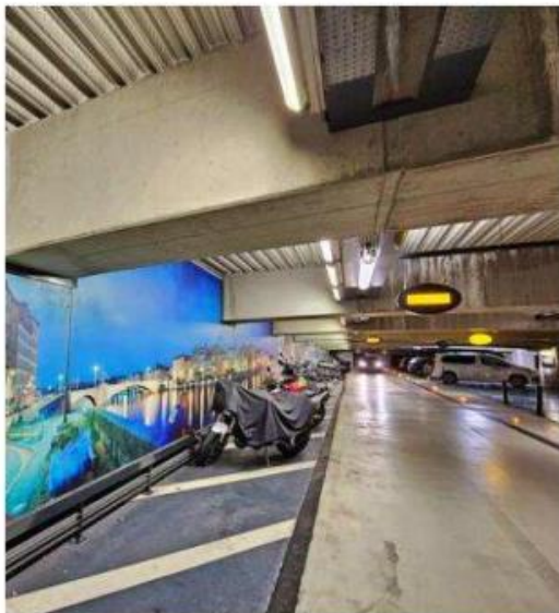
Le parking Saint-Georges sera fermé du 8 juillet au 1 er septembre. Photo Éric Baule
