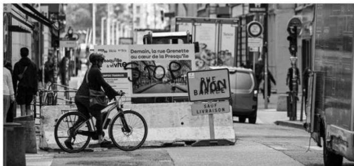
La rue Grenette dans le cadre du projet "Presqu'île à vivre" est désormais fermée aux voitures. Après des travaux réalisés sur les réseaux, elle sera réaménagée pour y accueillir, bus, vélos et piétons. Photo Maxime Jegat
