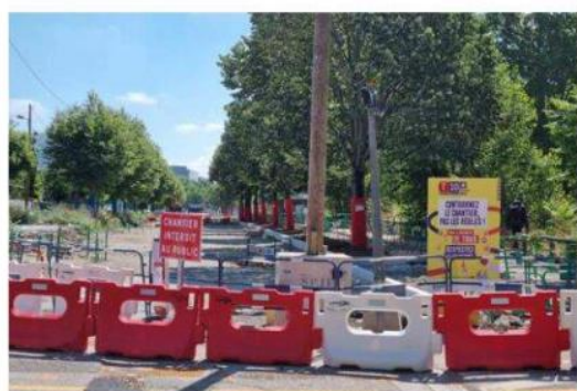
Les travaux du T10 impactent fortement la circulation. Photo Régis Barnes
