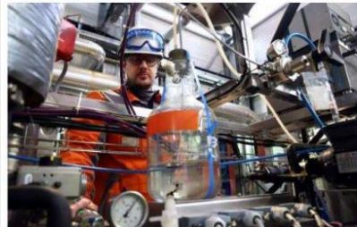
Le premier démonstrateur d'extraction de lithium géothermique a été installé à la centrale de Rittershoffen. Photo EBRA/DNA/Laurent Réa
