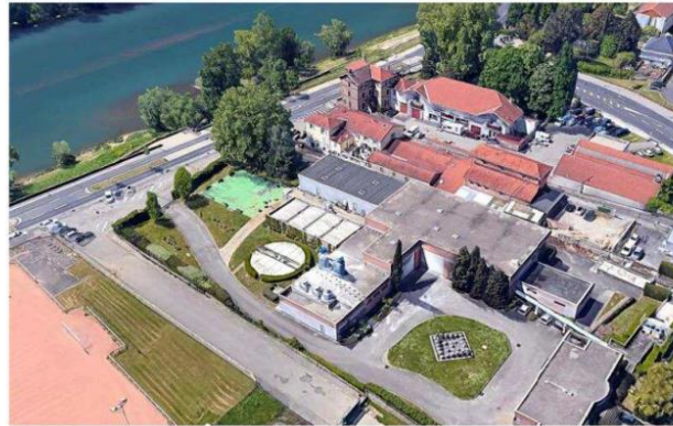
La station d'épuration de Fontaines-sur-Saône avait été mise en service en 1991. Elle est aujourd'hui sous-dimensionnée. Photo Capture écran Google Earth
