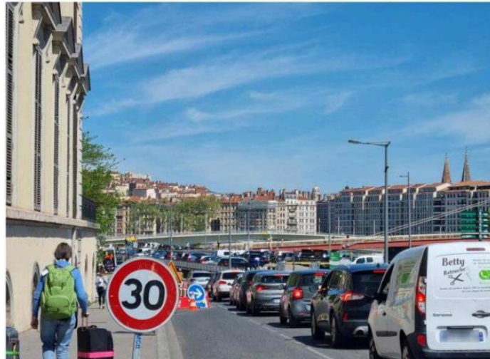
Quai Romain-Rolland : une voie de circulation a été neutralisée pour les besoins du chantier. Photo Aline Duret
