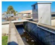
Une station d'épuration dans l'Ain. Photo F. Python
