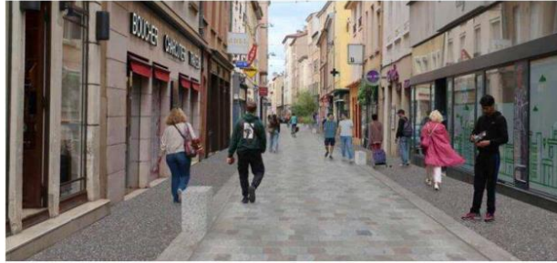
La nature des pavés lyonnais installés au centre de la rue du Mail piétonnisée a été pensée pour que le revêtement soit le plus plat possible. Visuel agence Folia
