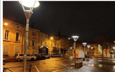
L'éclairage Led, priorité de la Ville, devrait permettre une très importante économie d'énergie. Photo Laurette Duranel
