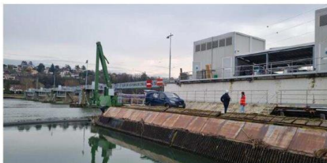
Les deux turbines de la centrale sont logées dans des trous de 6 mètres de profondeur au sein des deux groupes (les bâtiments blancs sur la photo). Photo Sandrine Mangelot
