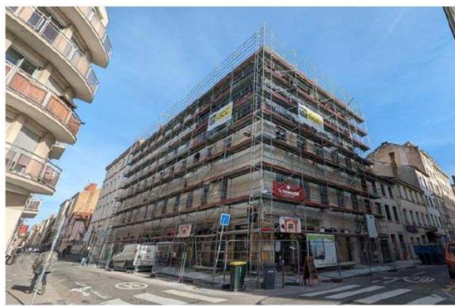
Le bâtiment à l'angle des rues Pasteur et Reinach compte désormais quatre étages contre deux auparavant. Cela a permis la création de dix logements supplémentaires. Photo Anne-Laure Wynar
