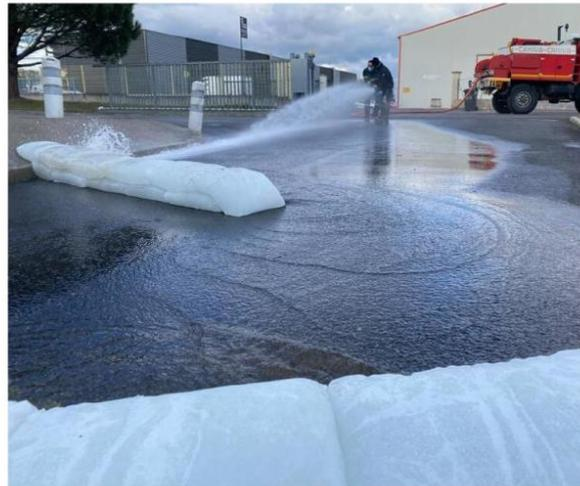
Les boudins anti-inondation mis au point par Ausec permettent d'absorber, de bloquer et de dévier les eaux et les boues lors d'une inondation. Photo fournie par Ausec
