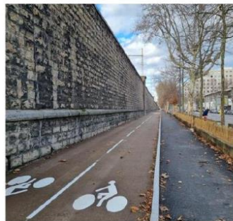
Sur le boulevard Stalingrad ici à hauteur de l'avenue Verguin, la voie lyonnaise n° 2 est terminée. Le trottoir et la piste cyclable de cette contre-allée seront mis en service courant février. Photo Nadine Micholin
